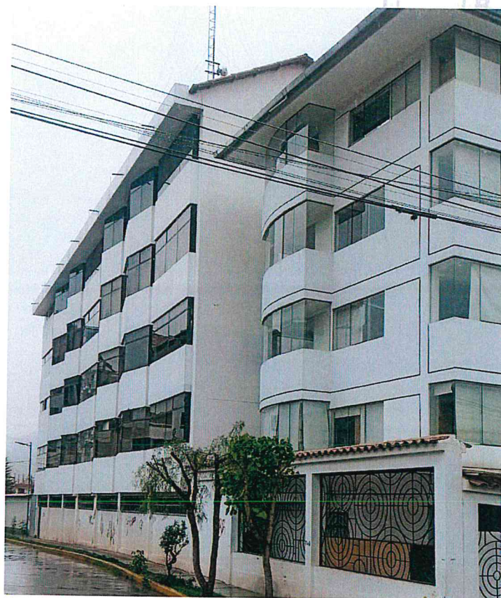
FACHADA BLOQUE A
